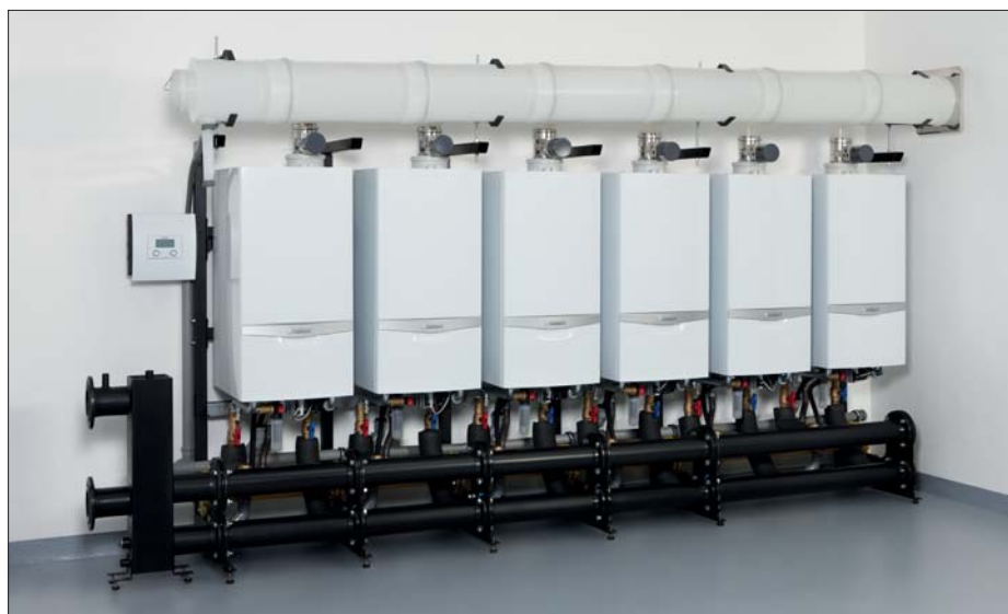
Kaskáda šesti kotlů v řadě (příklad montáže bez tepelné izolace)
